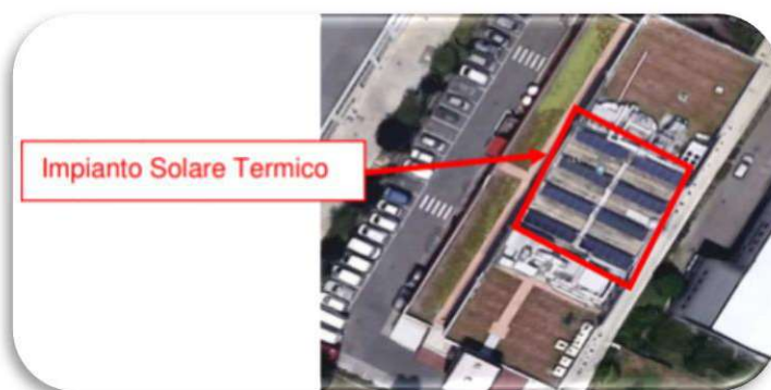
Figura 9: impianto solare termico
